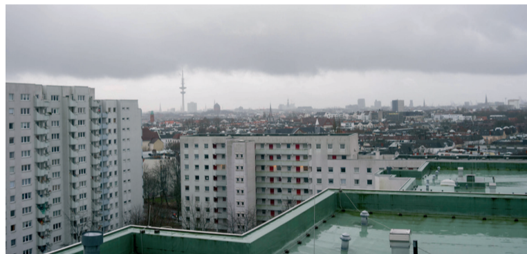
Die Lenzsiedlung – Blick von der 12. Etage
